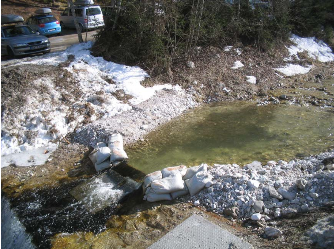
Nicht normgerecht! Restwassermenge nicht garantiert!
